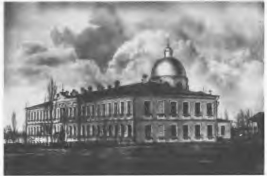
Корпус келій з трапезною церквою Козельщинського Різдва Пресвятої Богородиці монастир. Зображення поч. XX ст.
