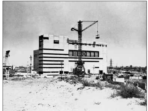
На будівництві комбінату. 1967 р.
